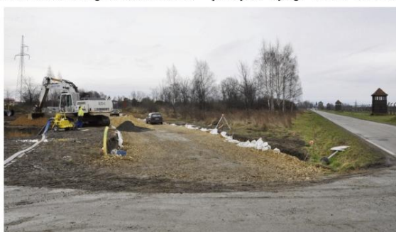
Budowa drogi odbarczającej w Brzezince. Fot. Lech Chodacki
